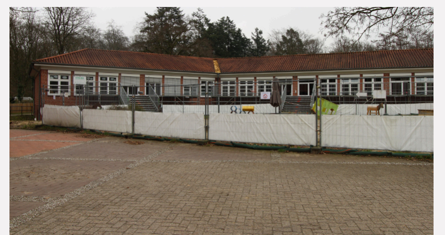
Umbau der ehemaligen Grundschule zum KuBiZ
